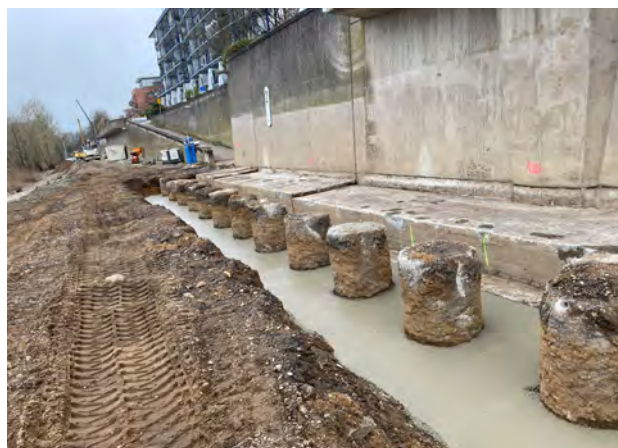
Die Lindemauer vor der Sanierung mit den neuen Bohrfahlköpfen / © StEB Köln
