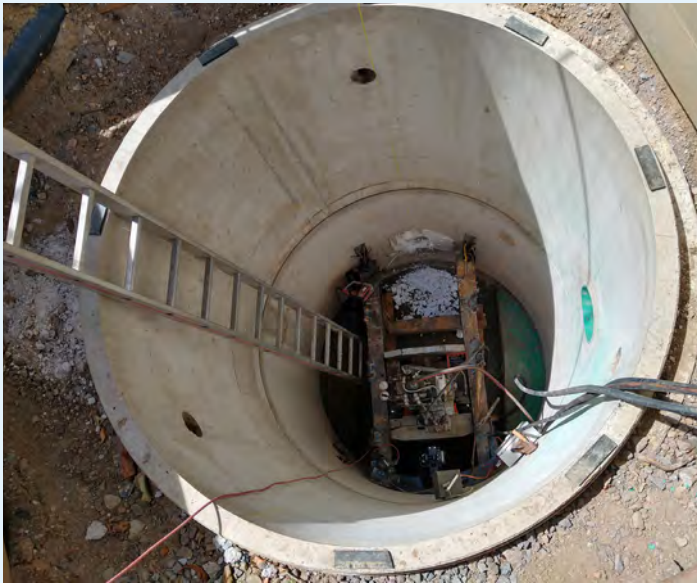
Startgrube Pilotrohrvortrieb für Kanalquerung Frankfurter Straße © StEB Köln
