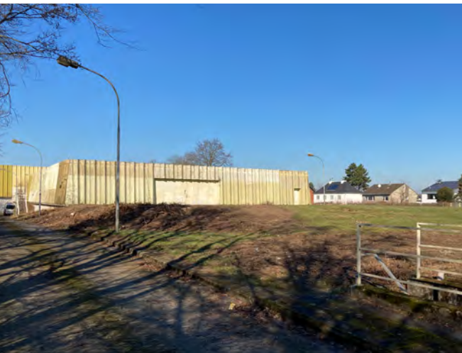
Altes bestehendes Pumpwerk Martinusstraße © StEB Köln
