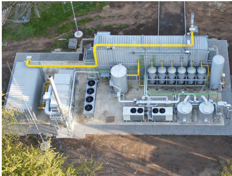
Biogasaufbereitungsanlage in der Bauphase / © StEB Köln, Marvin Moritz
