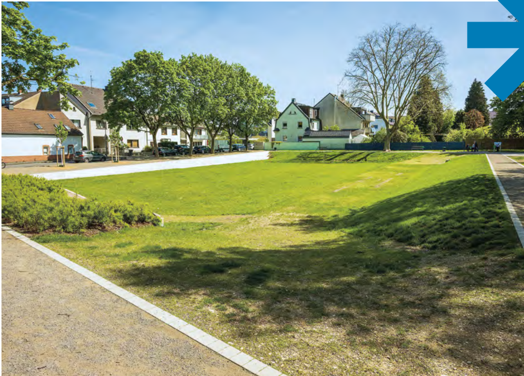
Retentionsfläche am Eiler Schützenplatz / © StEB Köln, Peter Jost
