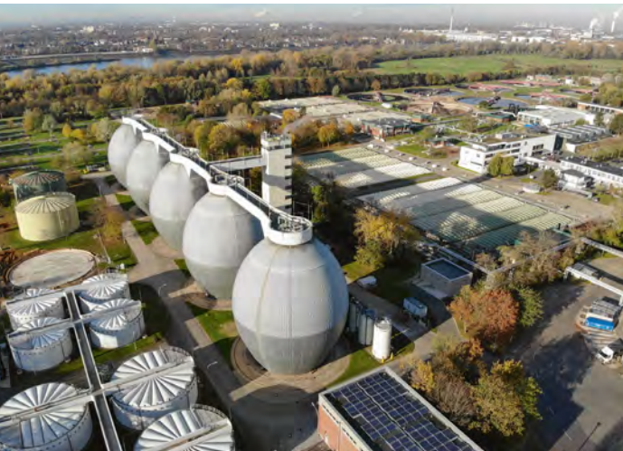
Klärwerk Stammheim © StEB Köln, Sabine Grothues
