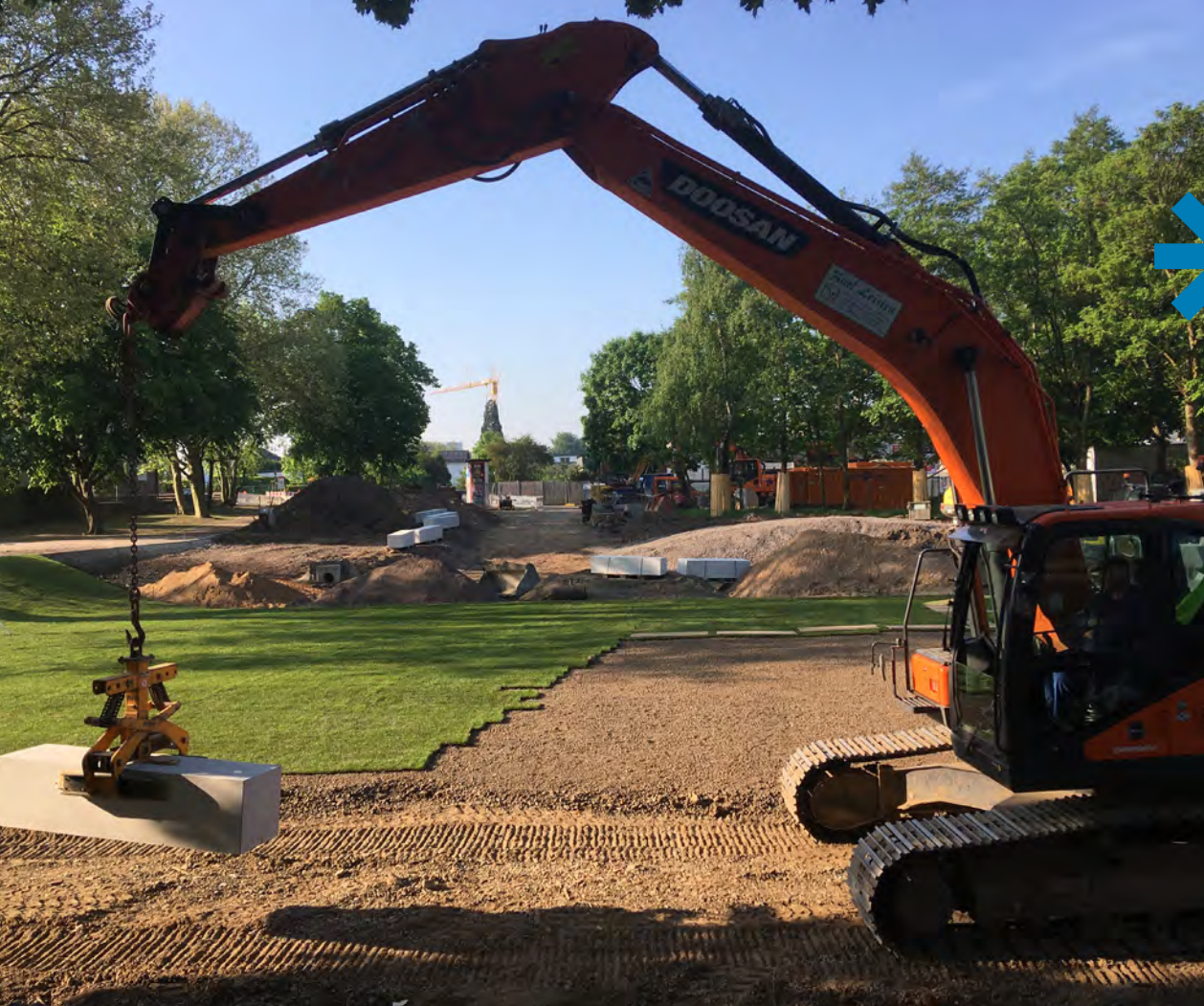
Bauarbeiten am Eiler Schützenplatz / © StEB Köln
