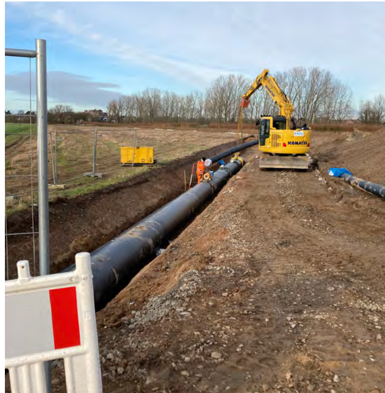
Leitungsverlegung für das Bauprovisorium / © StEB Köln
