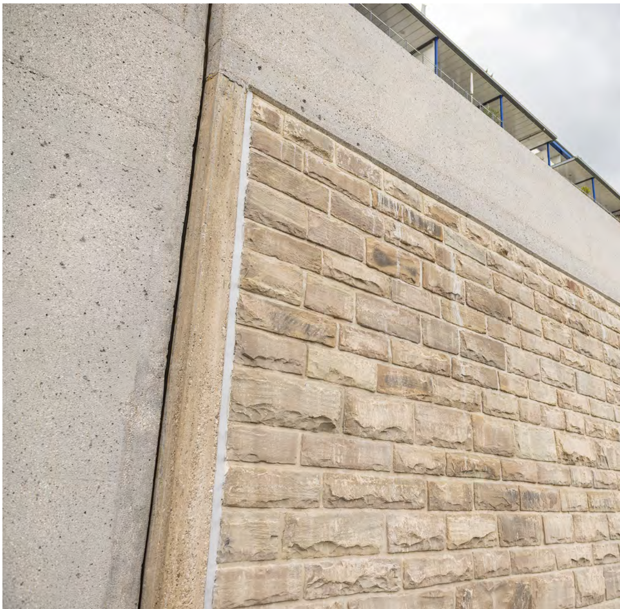
Saniertes (links) und erhaltenes Mauerwerk / © StEB Köln, Peter Jost
