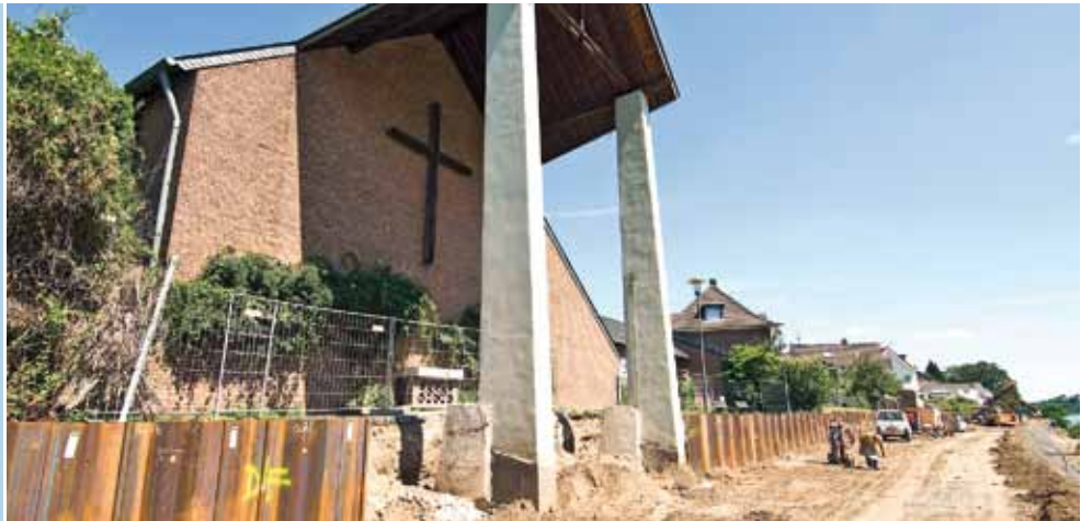
Fotos rechts: Bauarbeiten zum Hochwasserschutz in Köln-Sürth
