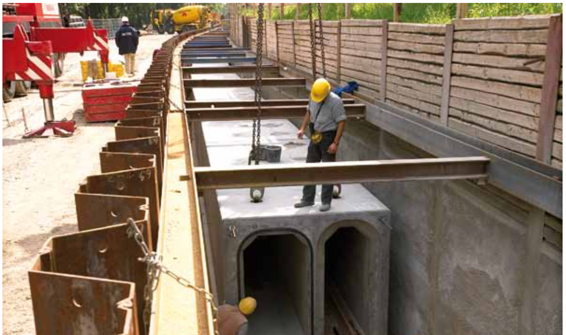
Einbau des Kombikanals (Qualmwasser und Mischwasser), Rodenkirchen Uferstraße
