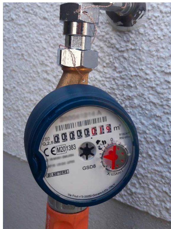
Beispiel eines Zapfhahnzählers mit Plombe
