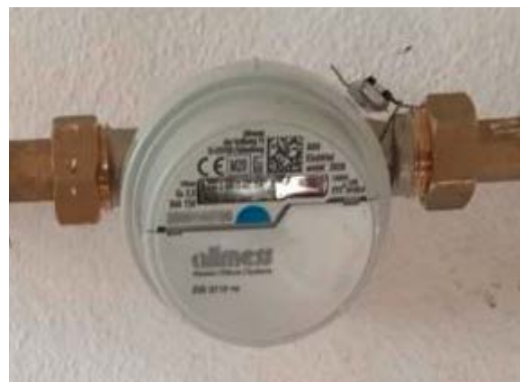
Beispiel eines fest eingebauten Zählers
