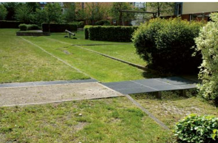
Abb. 34 – Ableitung von Regenwasser über eine offene Mulde
