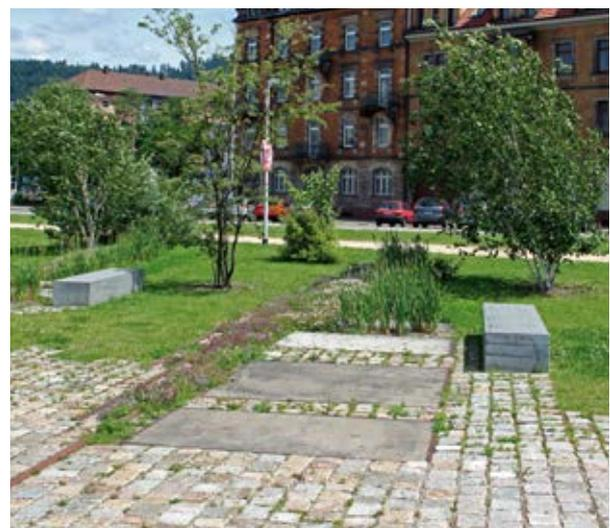
Abb. 97 – Versickerungsbeete und Fugenpflaster aus Naturstein
