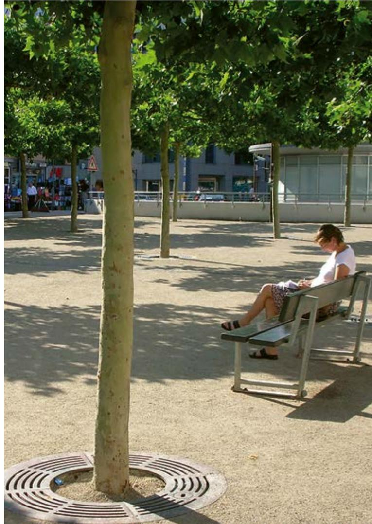
Abb. 24 – Platzfläche mit wassergebundener Decke
