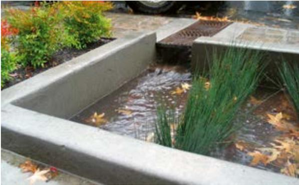
Abb. 29 – Zuleitung wenig belasteter Straßenabflüsse in ein Tiefbeet
