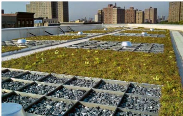
Abb. 46 – „Blaues Dach“ zum Rückhalt von Niederschlagsspitzen
