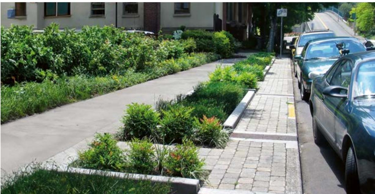
Abb. 25 – Versickerung über Tiefbeete im Straßenseitenraum
