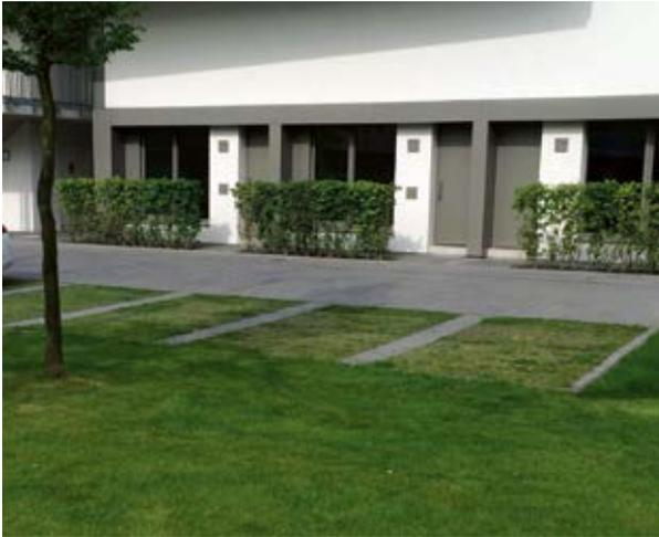
Abb. 22 – Wasserdurchlässiges Rasengitter auf Stellplatzfläche
