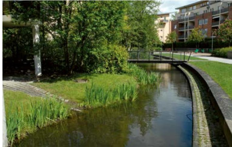
Abb. 19 – Offene Wasserfläche als Retentionsraum für Regenabflüsse
