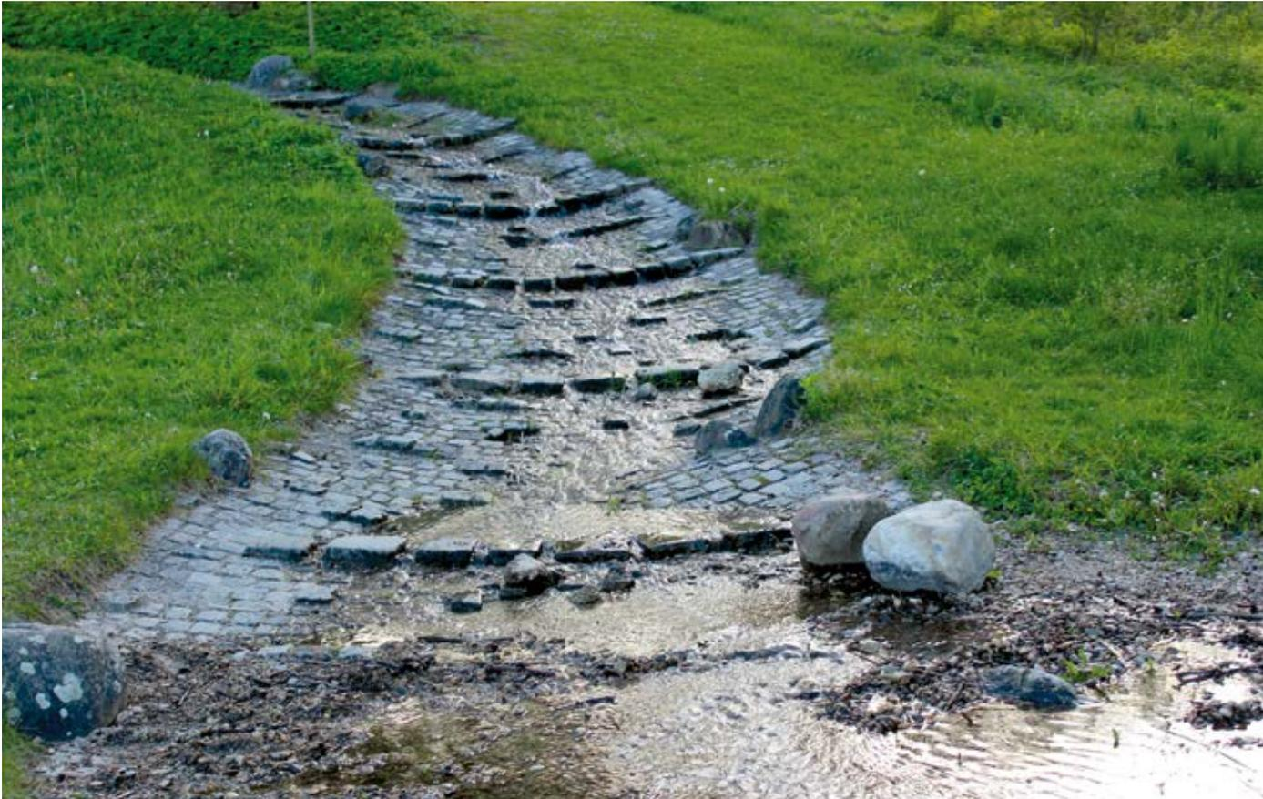
Abb. 17 – Beispiel für eine offene Ableitung von Regenwasser
