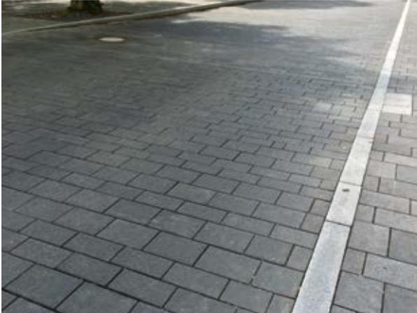
Abb. 49 – Abgesenkte Straße zum temporären Rückhalt von Abflussspitzen
