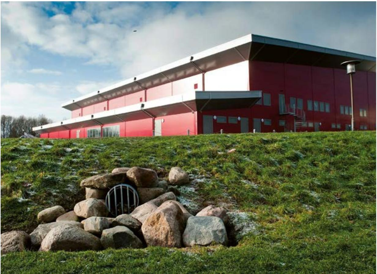
Abb. 89 – Auslass in Versickerungsmulde
