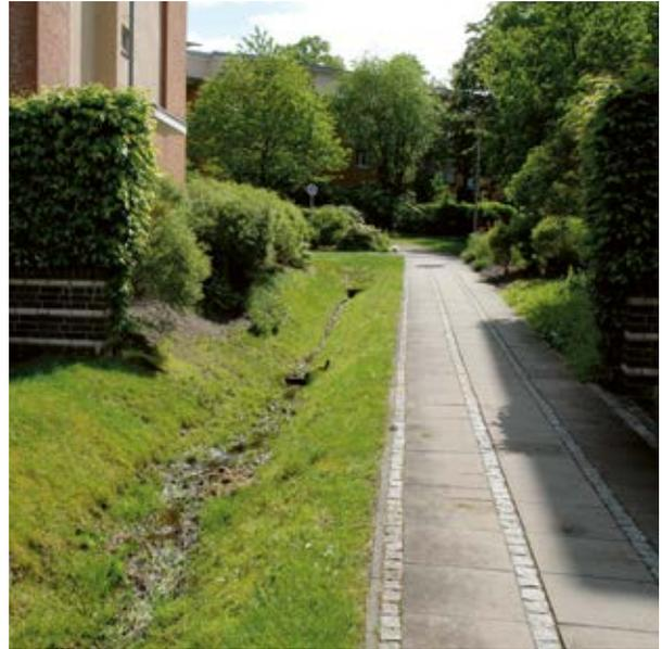
Abb. 36 – Ableitung über Entwässerungsgraben
