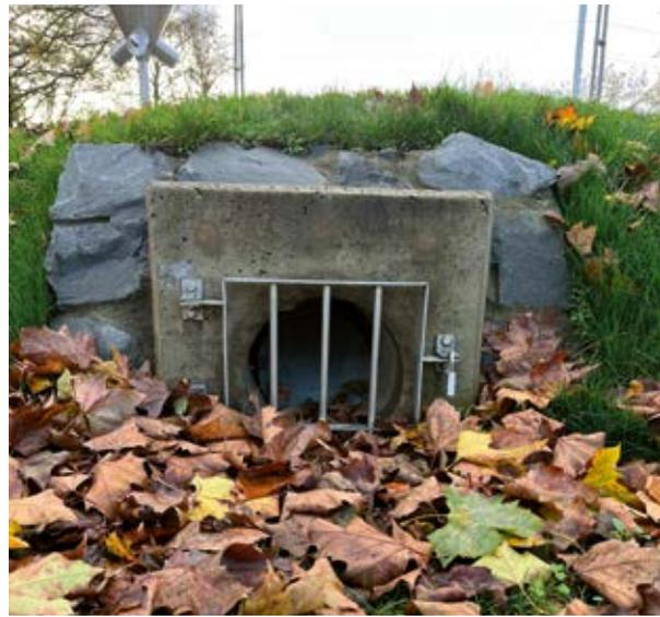
Abb. 75 – Unterirdischer Zulauf vom Hirschgraben in den Retentionsraum
