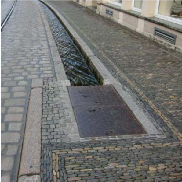
Abb. 35 – Permanente Wasserführung in offener Kastenrinne
