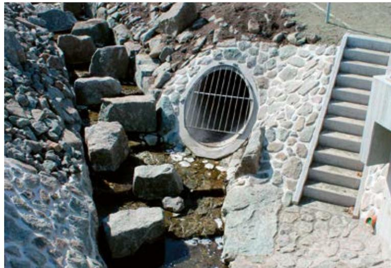
Abb. 56 – Zuleitung von Regenwasser in den Graben
