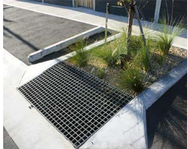
Abb. 27 – Einleitung wenig belasteter Straßenabflüsse in Pflanzgrube
