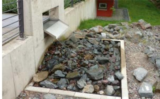
Abb. 30 – Ableitung von Gehwegabflüssen in eine Versickerungsanlage
