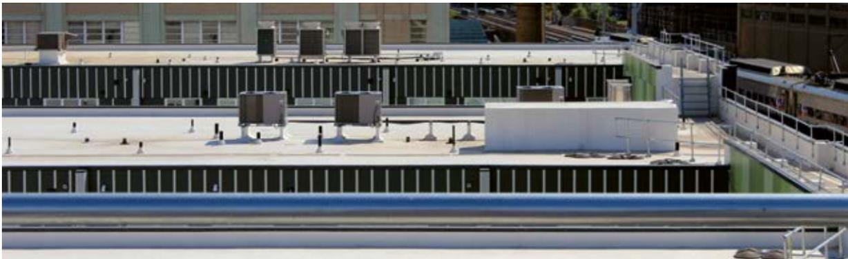
Abb. 42 – Dach mit erhöhter Regenauffang- und Rückhaltekapazität
