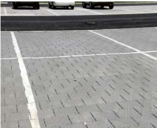
Abb. 23 – Versickerungsfähiges Pflaster
