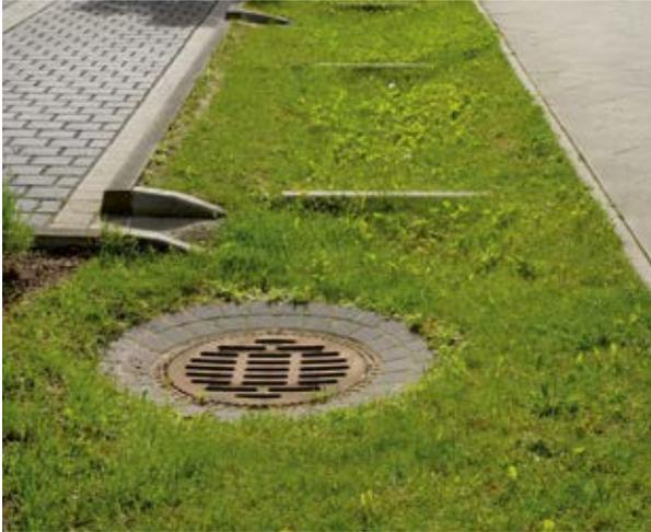
Abb. 26 – Dezentrale Straßenentwässerung über Muldenkaskaden
