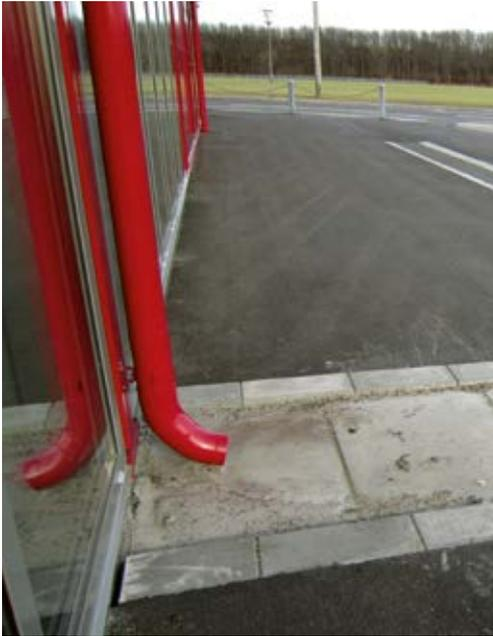
Abb. 87 – Ableitung der Dachabflüsse in Kastenrinne
