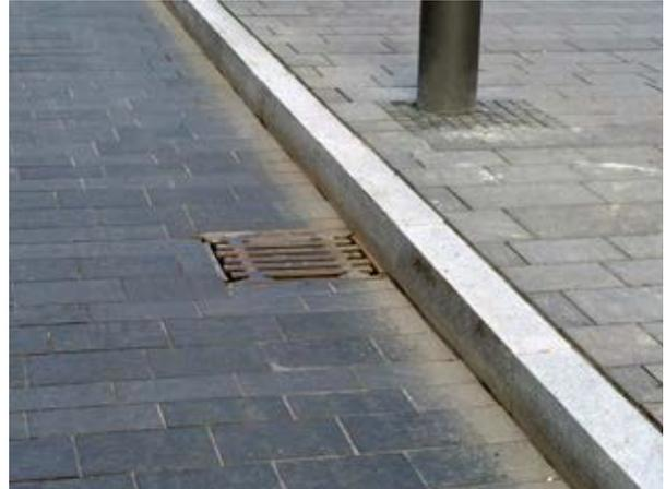
Abb. 50 – Erhöhte Bordsteine zur Verbesserung des Regenwasserabflusses
