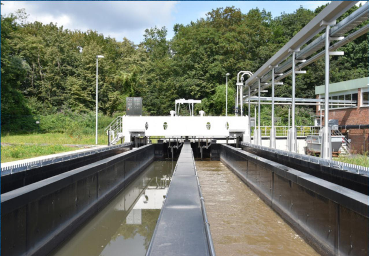
**Der Zahn der Zeit nagt am Klärwerk (KW) Köln-Rodenkirchen: Altersbedingte Schädigungen an der fast 50 Jahre alten Bausubstanz des Sandfangs sowie eine veraltete maschinentechnische Ausrüstung machen für die Stadtentwässerungsbetriebe Köln (StEB Köln) – Betreiber des Klärwerks – die Errichtung eines neuen, ebenfalls zweistraßig belüfteten Sandfangs notwendig.**
