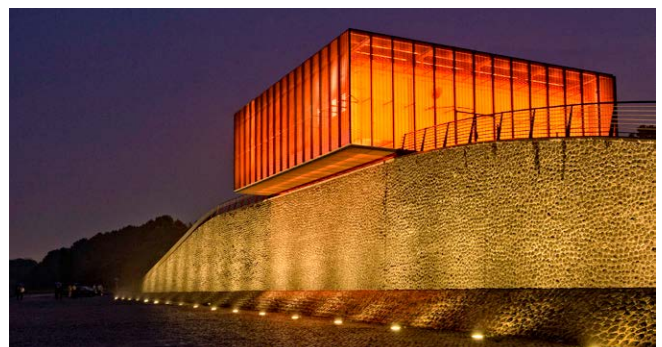
Pumpwerk Schönhauser Straße
