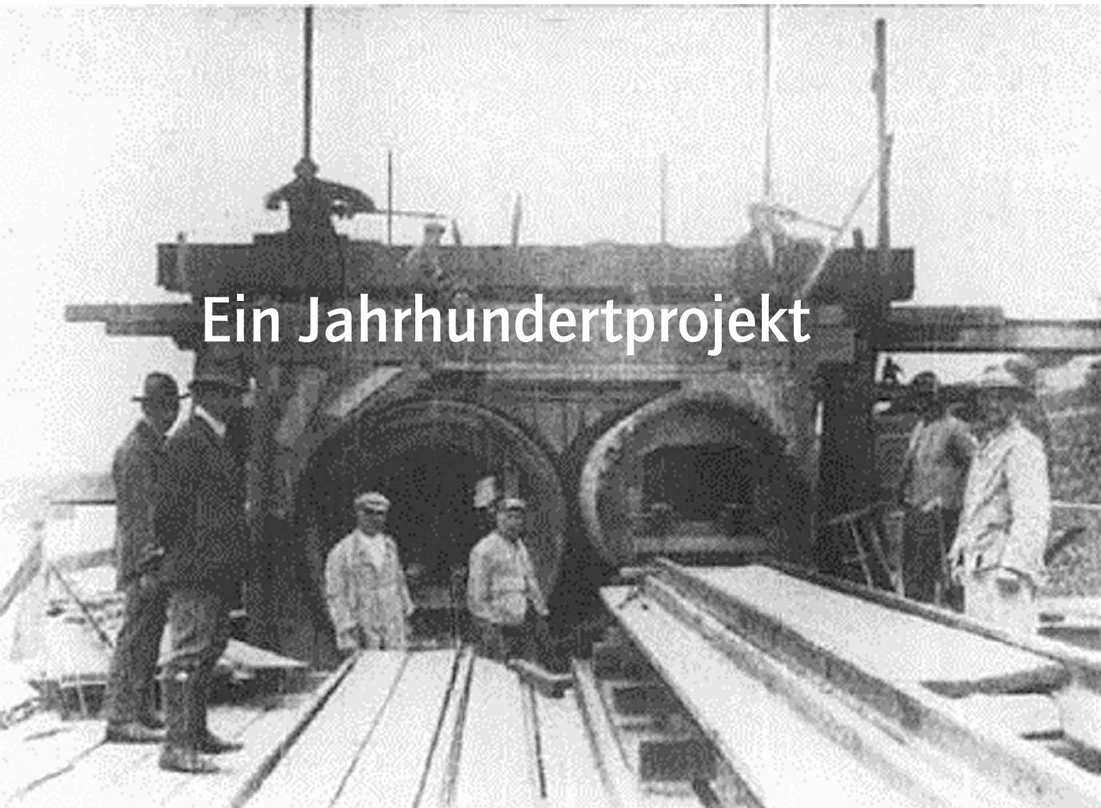
Foto oben: Baustelle Düker, um 1930 (Bildquelle: Stadtbaurat Werken, Der Anfang und Werdegang der Kanalisation in Köln, in: Der West-Bau 5/1930, S.1-12)
