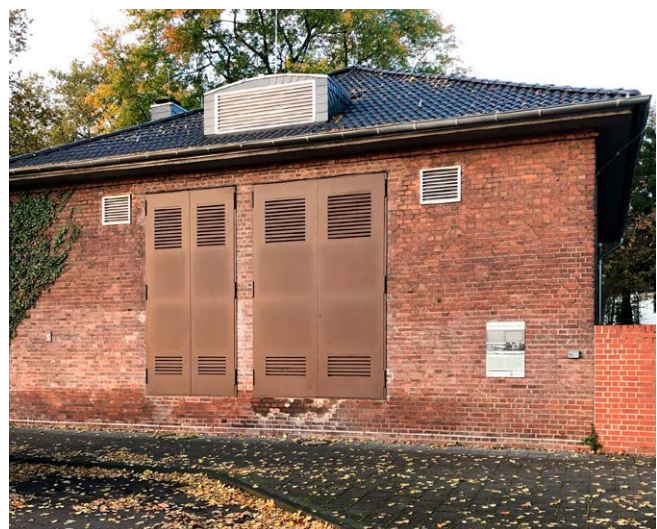
Abb. 4: Betriebsgebäude am Niehler Damm
