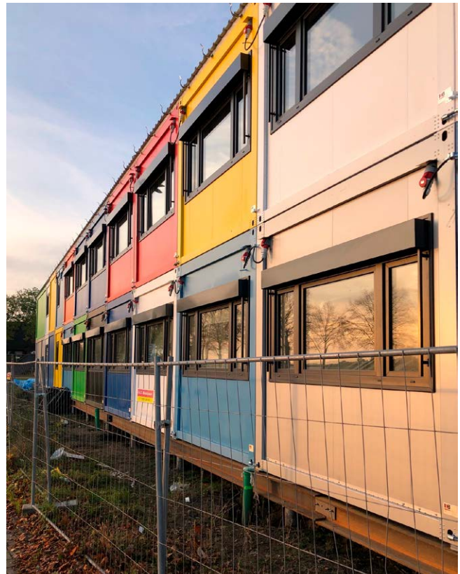
Abb. 3: Containerschule GGS Halfengasse im Bauzustand
