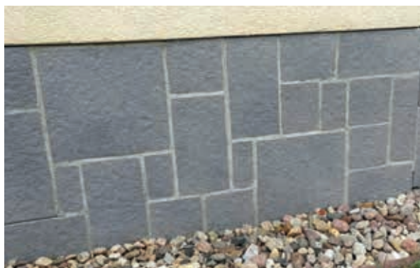
Abb. 32 – Abdichtung mit Steinzeugfliesen
