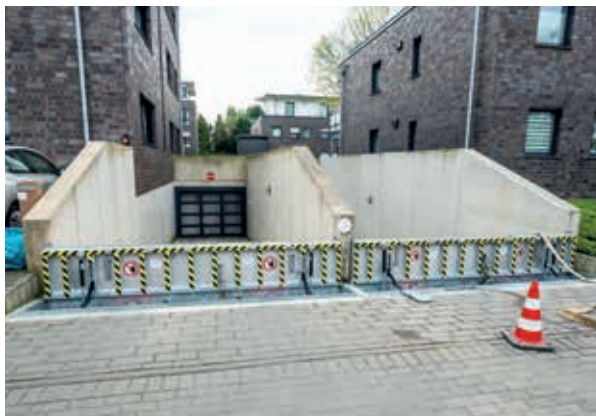
Abb. 24 – Automatisch schließendes Klappschott
