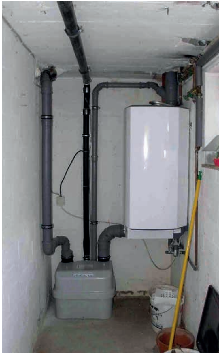
Abb. 43 – Hebeanlage
