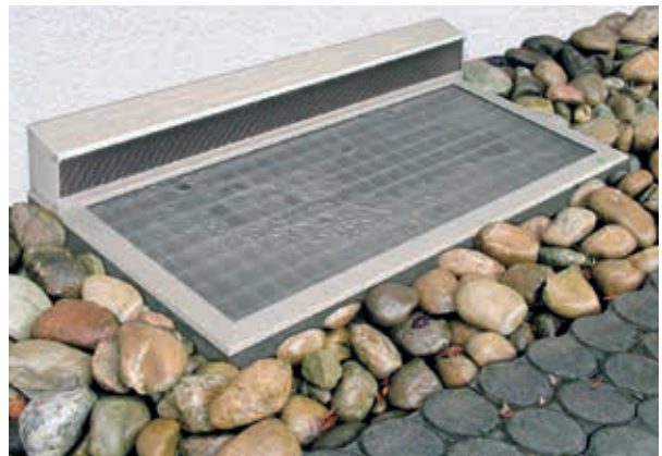
Abb. 28 – Abgedichteter Lichtschacht
