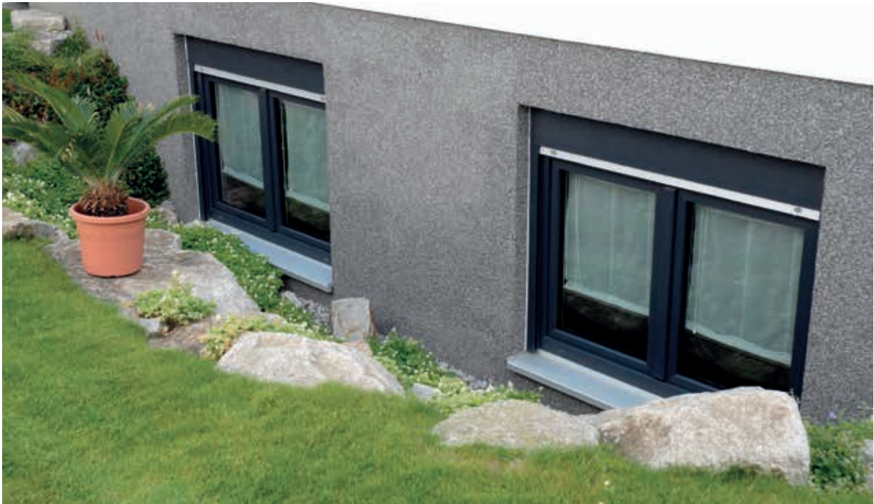
Abb. 20 – Kellerfenster mit Sockel
