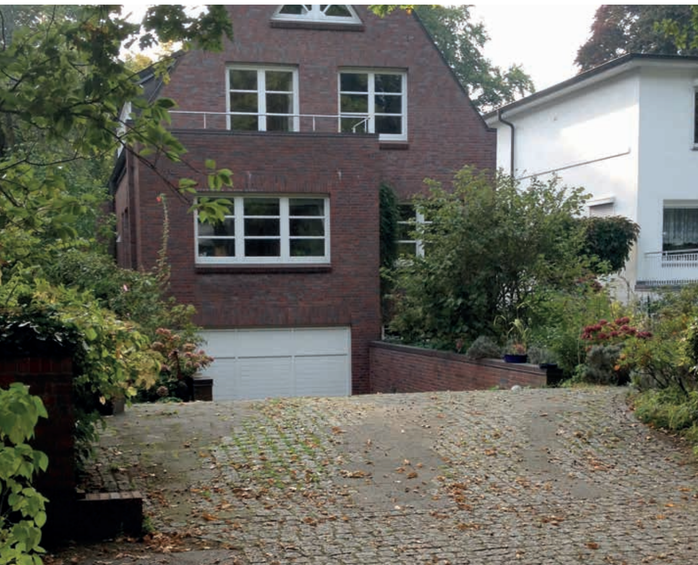
Abb. 16 – Garagenzufahrt mit Schutzschwelle
