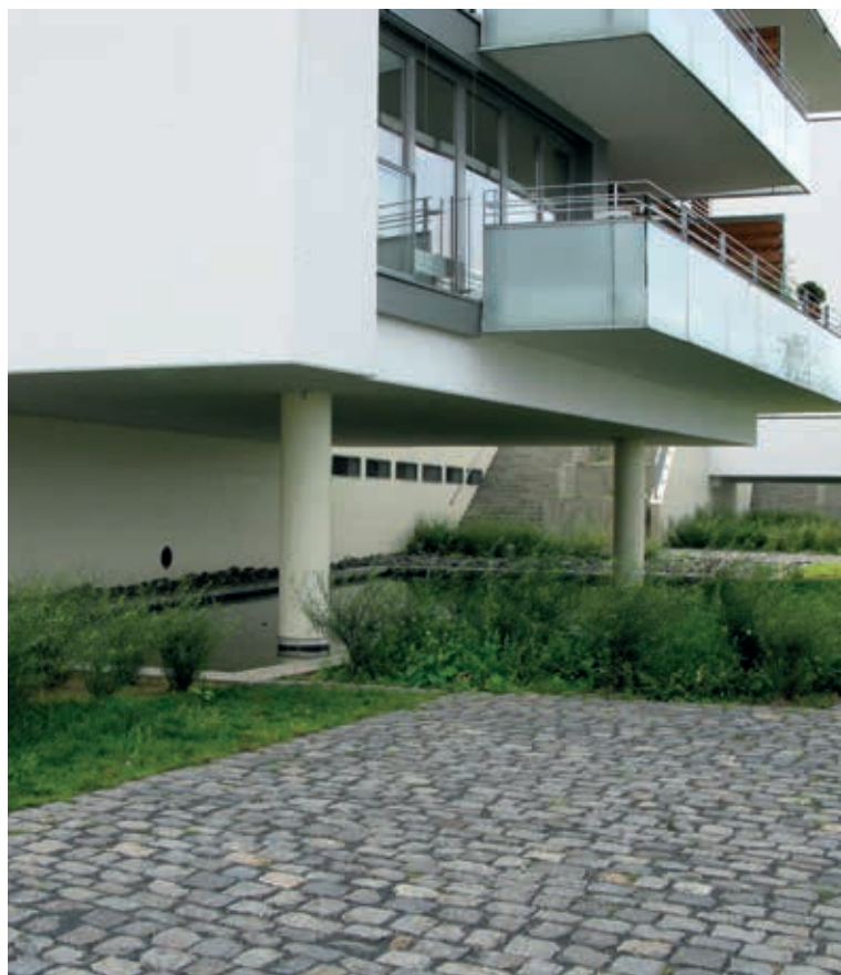
Abb. 34 – Aufständering eines Gebäudes
