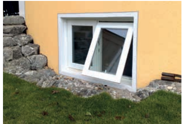
Abb. 27 – Druckwasserdichte Fenster
