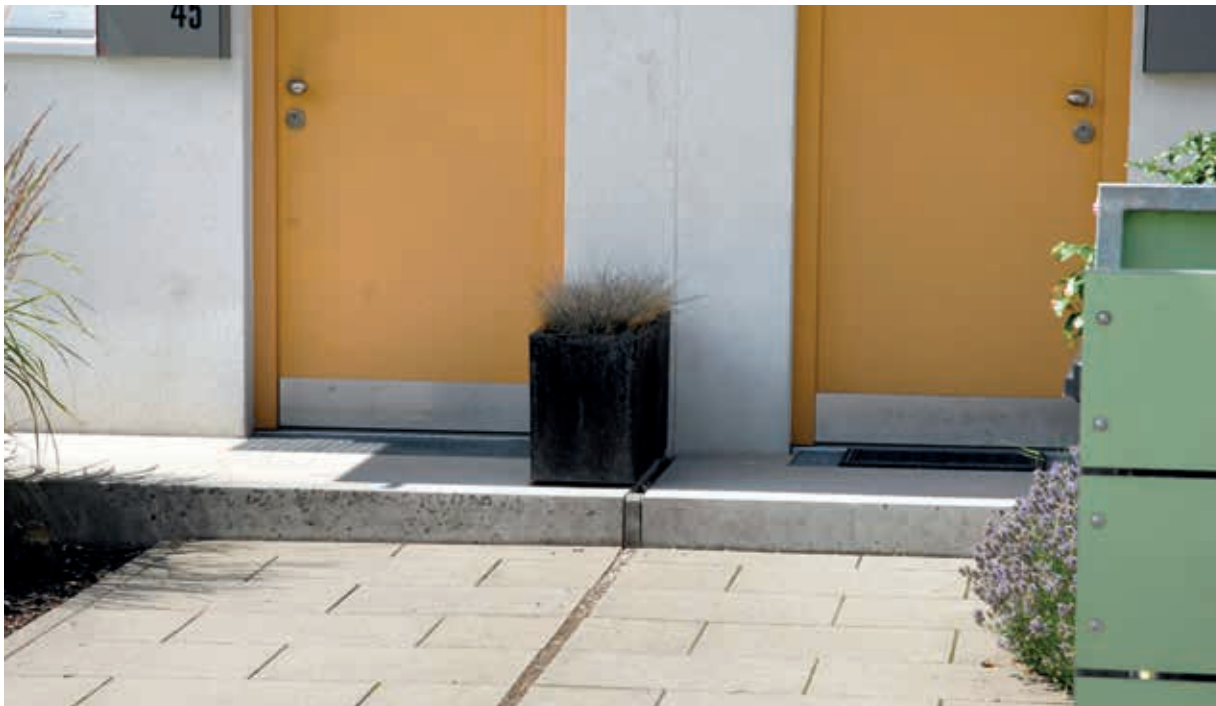
Abb. 22 – Aufkantung am Gebäudezugang
