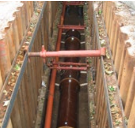
Verlegte Abwasserrohre
