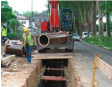
Verlegen der Abwasserrohre im hergestellten Graben
