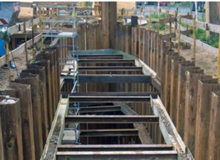
Eine Kanalbaugrube mit stützendem Verbau
