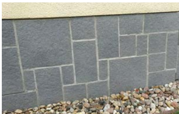
Abb. 32 – Abdichtung mit Steinzeugfliesen
