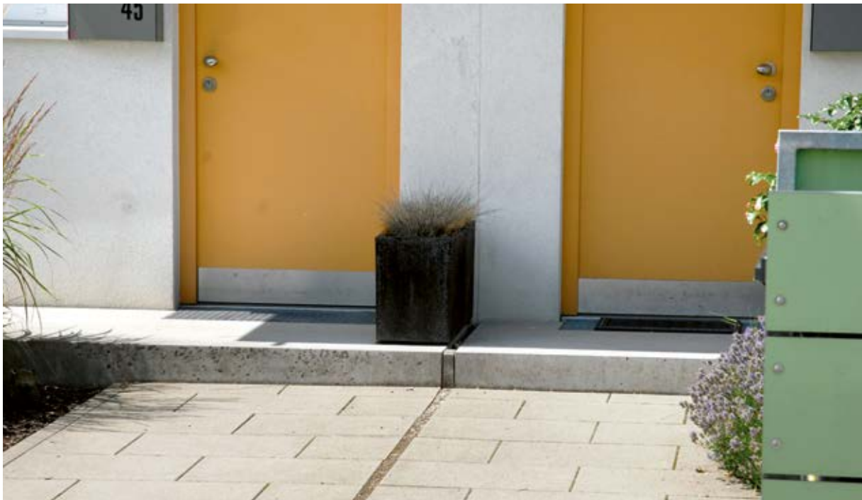
Abb. 22 – Aufkantung am Gebäudezugang
