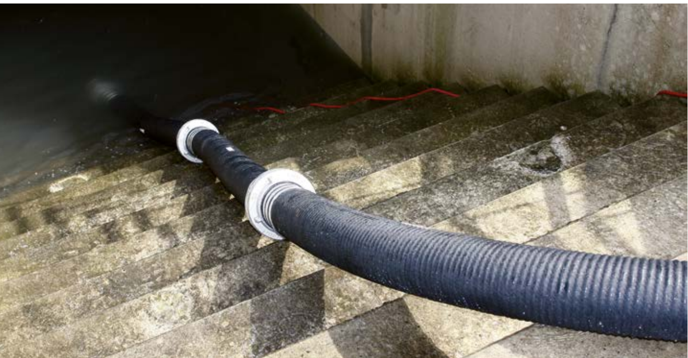
Abb. 2 – Abpumpen eines überfluteten Treppenbereichs
