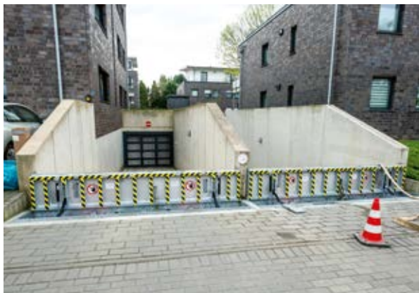
Abb. 24 – Automatisch schließendes Klappschott
