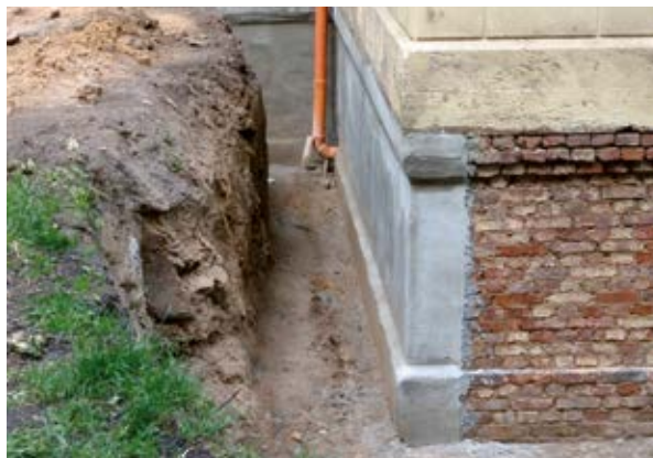
Abb. 31 – Wasserdichter Sperrputz
