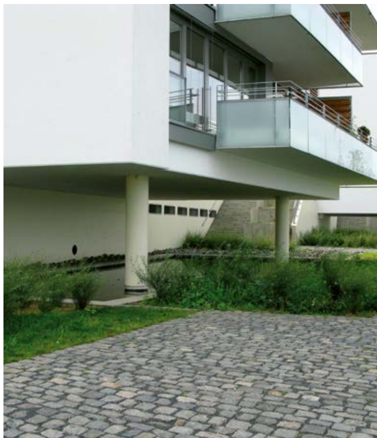
Abb. 34 – Aufständering eines Gebäudes
