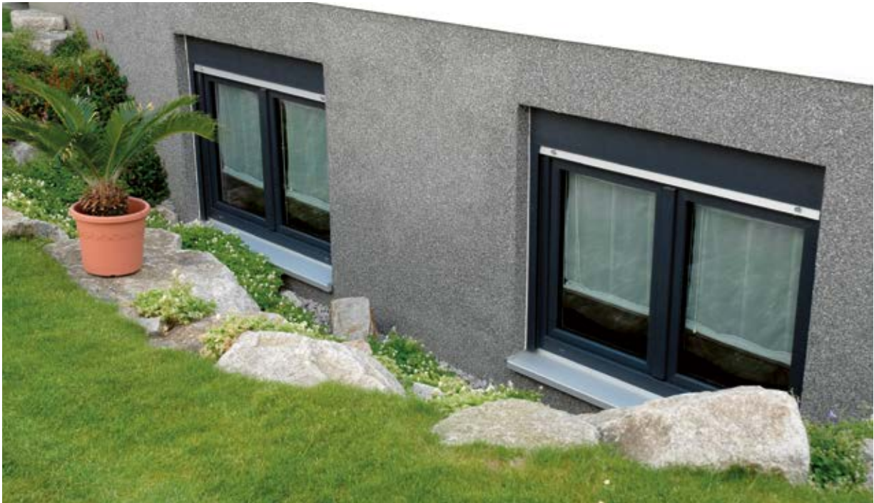
Abb. 20 – Kellerfenster mit Sockel
