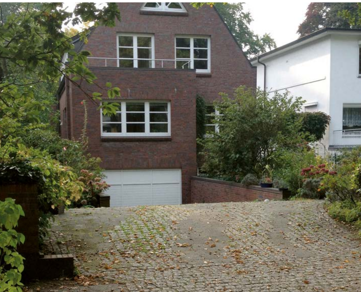
Abb. 16 – Garagenzufahrt mit Schutzschwelle
