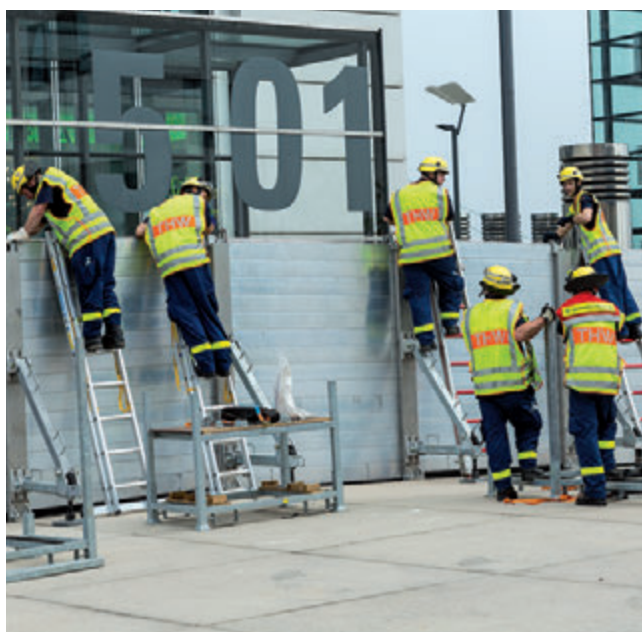
Aufbauübung am Tiefgaragenabgang Rheinauhafen
