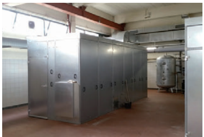
Neubau der Schlamm-entwässerung
