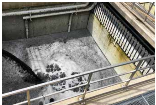
Nasses Einspülen granulierter Aktivkohle ins Filterbecken
