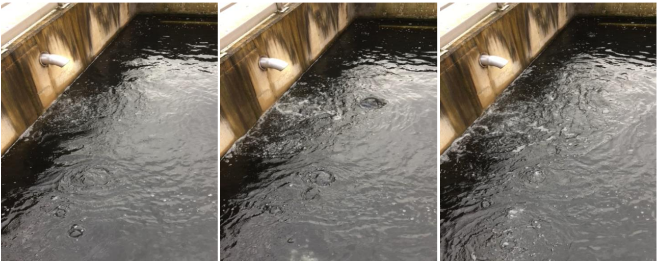
Bild 8: Wirbelbetteffekt im GAK-Filter durch Mitriss von Luftlinsen
