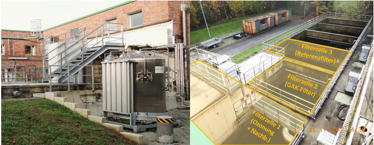
Bild 5: Pilotanlage im Klärwerk Köln-Rodenkirchen (links: Seitenansicht, rechts: schräge Draufsicht)
